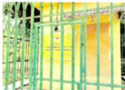
Sebuah rumah yang rosak di Janda Baik, Pahang selepas berlaku gempaan di Janda Baik dan Bukit Tinggi.
